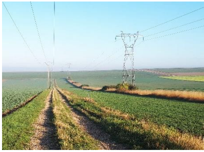
Pylônes électriques à la « Fossembert » (Ecosphère, 2018)
