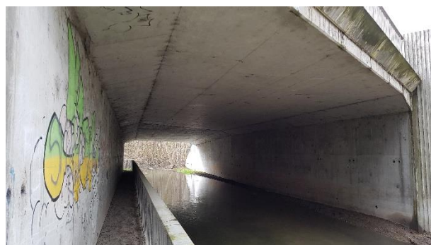
Pont près de Pogny possédant des joints de dilatation et des barbacanes abritant probablement une colonie de Murin sp. (Ecosphère)
