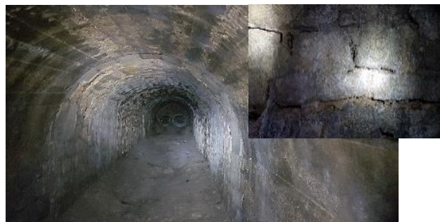
Intérieur du tunnel avec certaines parties favorables aux chauves-souris avec des interstices entre les pierres maçonnées (Ecosphere)
